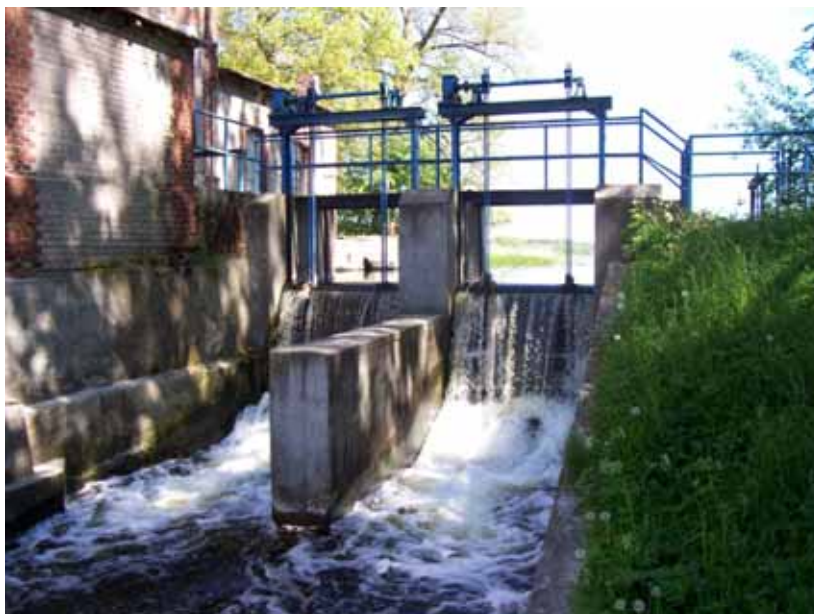
Fot. 2. Jaz na rzece Krępa w Marianowie (fot. A. Tański ) Photo. 2. Weir in the Krępa River in Marianowo (photo. A. Tański )
